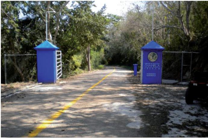
Se construyó un portón de acceso en la entrada principal a la Estación, específicamente en el lindero sur de la estación. Este nuevo portón contará con un mecanismo automático con tarjetas y cámara de vigilancia. Además, el portón podrá abrirse remotamente desde la administración
