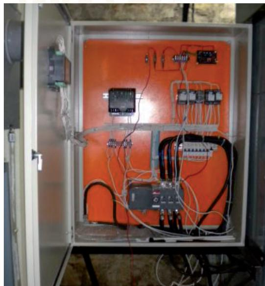
**El módulo de transferencia de la Planta Eléctrica** se actualizó con una transferencia de 250 amps. y un módulo digital electrónico para su mejor funcionamiento.
